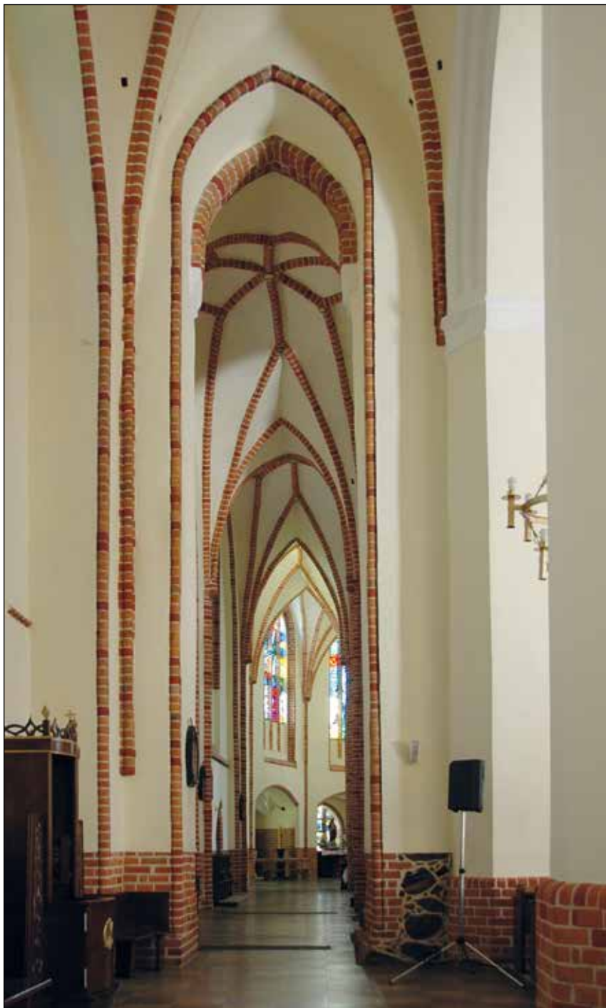
Ryc. 14. Nawa północna obejścia prezbiterium. Widoczna wąska arkada w miejscu styku z korpusem nawowym. Fot. M. Ober
