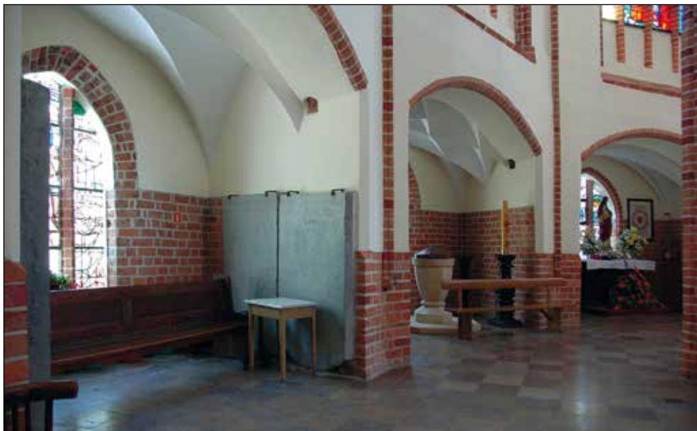
Ryc. 15. Kaplice po północno-wschodniej stronie obejścia prezbiterium. Widoczne sklepienia kryształowe. Fot. M. Ober
