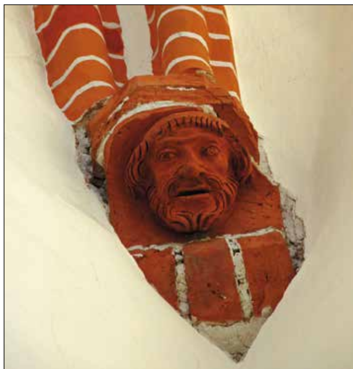
Ryc. 16. Maski – wsporniki żeber sklepiennych w obejściu prezbiterium. Fot. M. Ober
