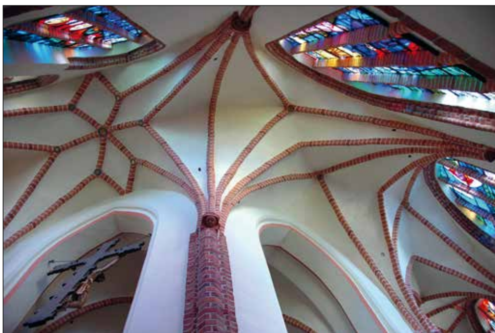
Ryc. 12. Widok na sklepienie obejścia prezbiterium. Fot. M. Ober
