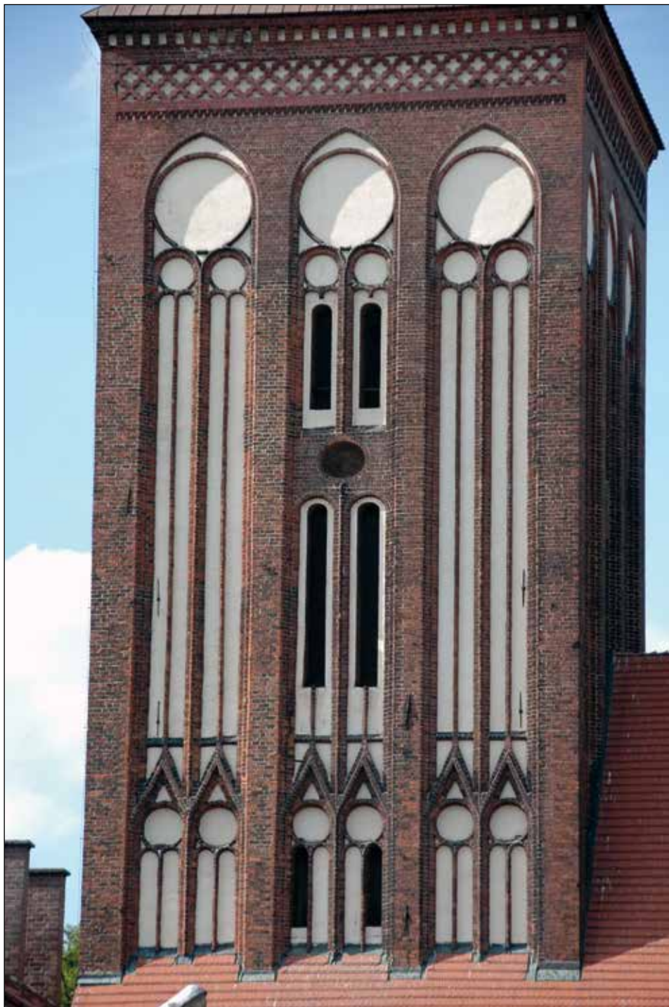
Ryc. 8. Dekoracja blendami typu stargardzkiego w południowej ścianie wieży. Fot. M. Ober
