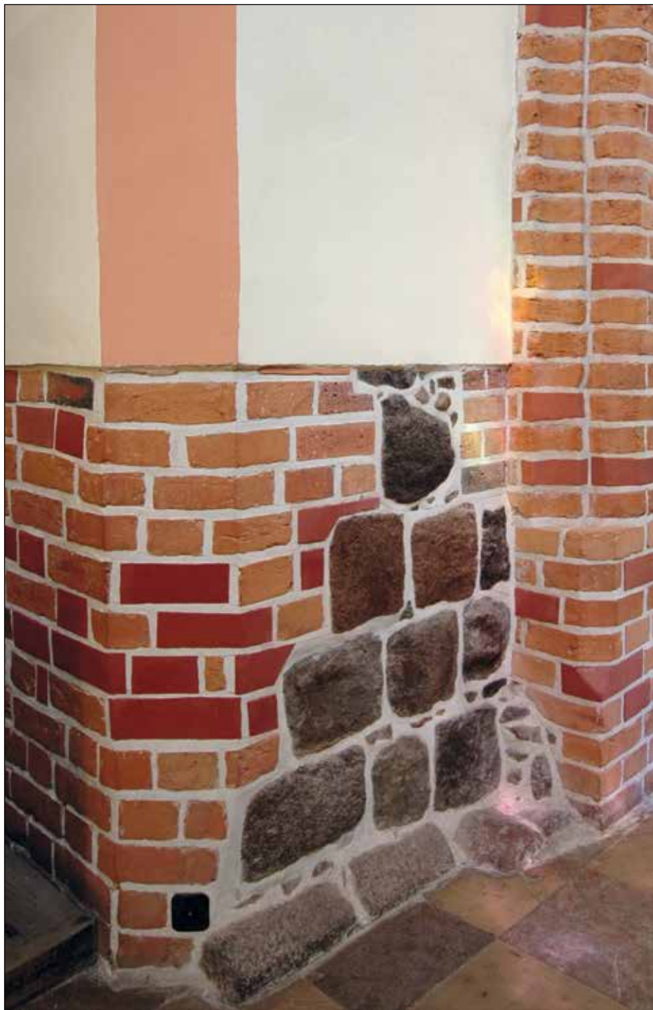
Ryc. 1. Filar w prezbiterium z wtórnie użyтыми granitowymi kwadrami z kościoła z XIII w. Fot. M. Ober
