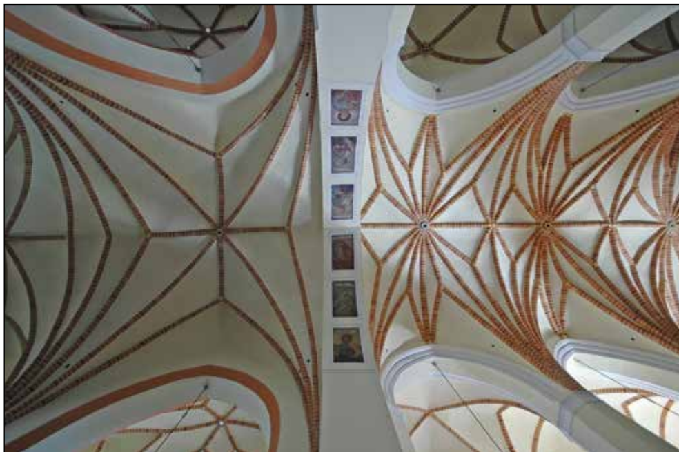
Ryc. 11. Widok na sklepienia nawy głównej chóru (po lewej) i korpusu (po prawej). Fot. M. Ober
